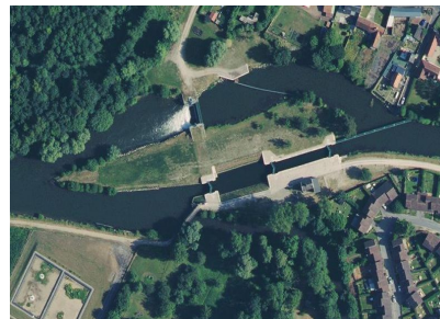
Vue aérienne de l'écluse de Pont-Rémy Google Satellite
